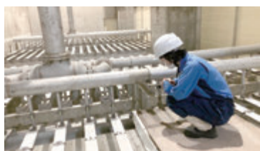
現地工事の様子
